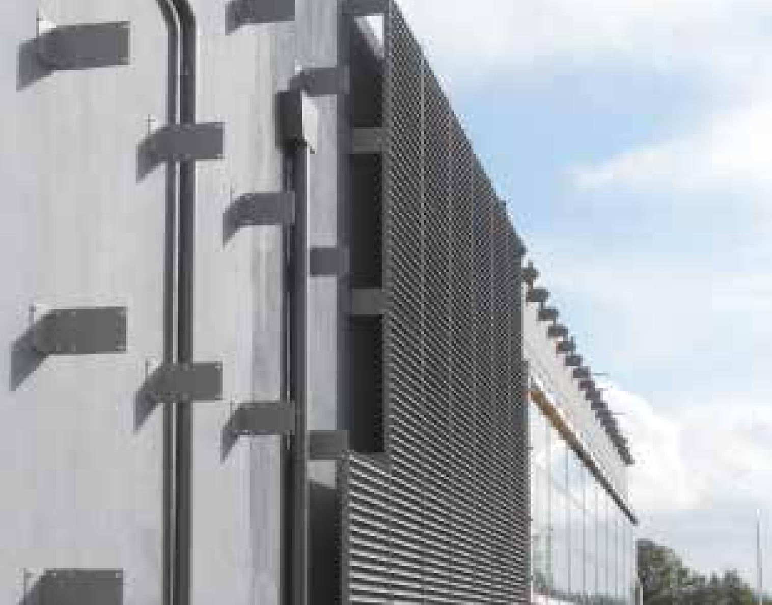
**Tipologia di grigliato:** Pressato incrociato e rinforzato con saldatura a filo
