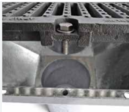
VITI E DADI DI BLOCCAGGIO in acciaio Inox
